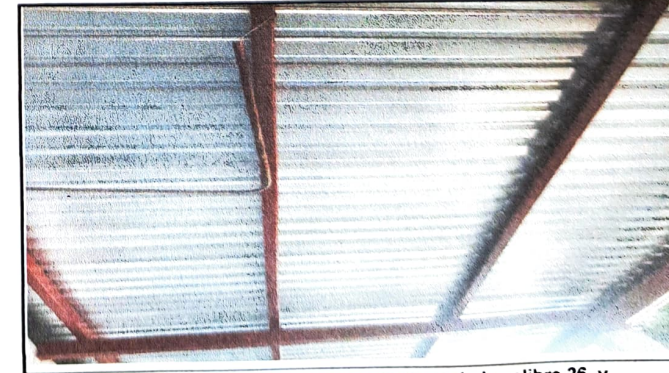
Foto 6: sustitución de lamina por lamina troquelada calibre 26, y sustitución de de soporte de metal por metal
