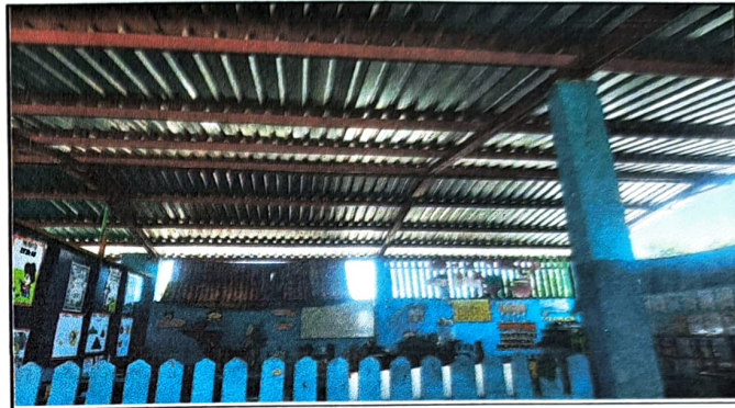
Foto 2: sustitución de lamina por lamina troquelada calibre 26, y sustitución de de soporte de metal por metal
