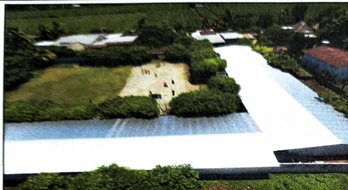
Foto 1: sustitución de lamina por lamina troquelada calibre 26, y sustitución de de soporte de metal por metal
