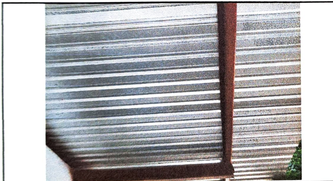
Foto 3: sustitución de lamina por lamina troquelada calibre 26, y sustitución de de soporte de metal por metal
