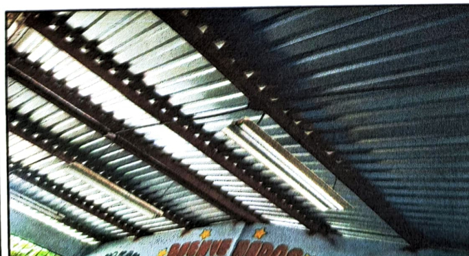
Foto 5: sustitución de lamina por lamina troquelada calibre 26, y sustitución de de soporte de metal por metal
